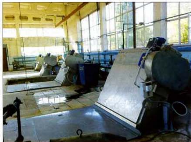
Рис. 3. Цех механической очистки после замены оборудования
