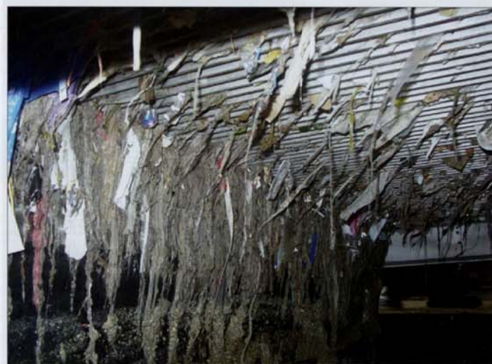
Рис. 2. Фильтровальное полотно стержневой решетки с перемичкой, опутанное волокнистыми включениями
