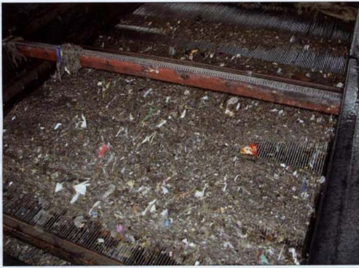
Рис. 3. Фильтровальное полотно стержневой решетки с прозором 6 мм, полностью забитое мусором
