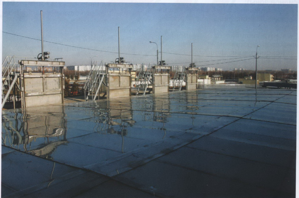
Вид перекрытий отстойников и одного из подводных каналов на КОС
