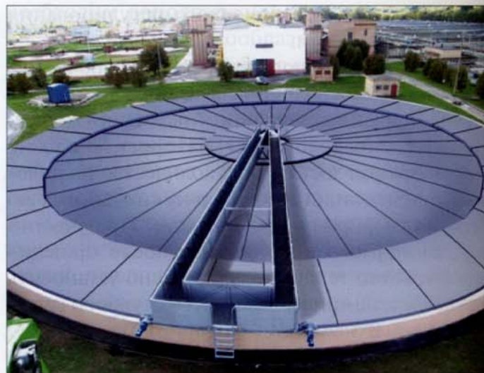
Рис. 6. Перекрытие конструкции первичного отстойника
