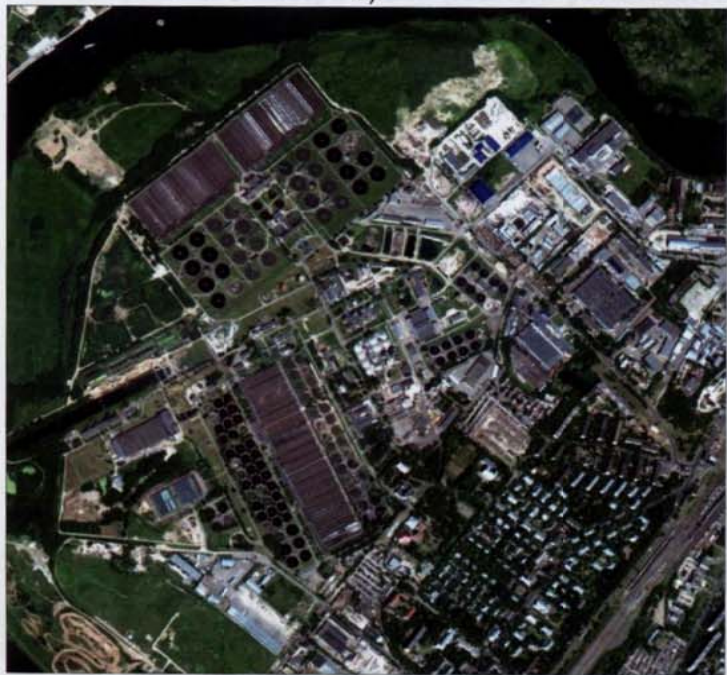
Рис. 1. Курьяновские очистные сооружения а – после запуска в эксплуатацию (1950-е годы); б – в настоящее время
