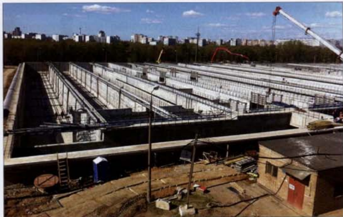
Рис. 7. Панорама строительства аэротенков
