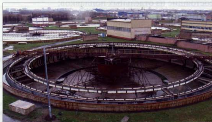
Рис. 4. Илоскреб марки ИПО в первичном отстойнике
