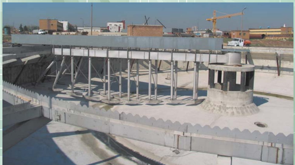
Рис. 7. Илосос марки СО-54. Новокурьяновские очистные сооружения
