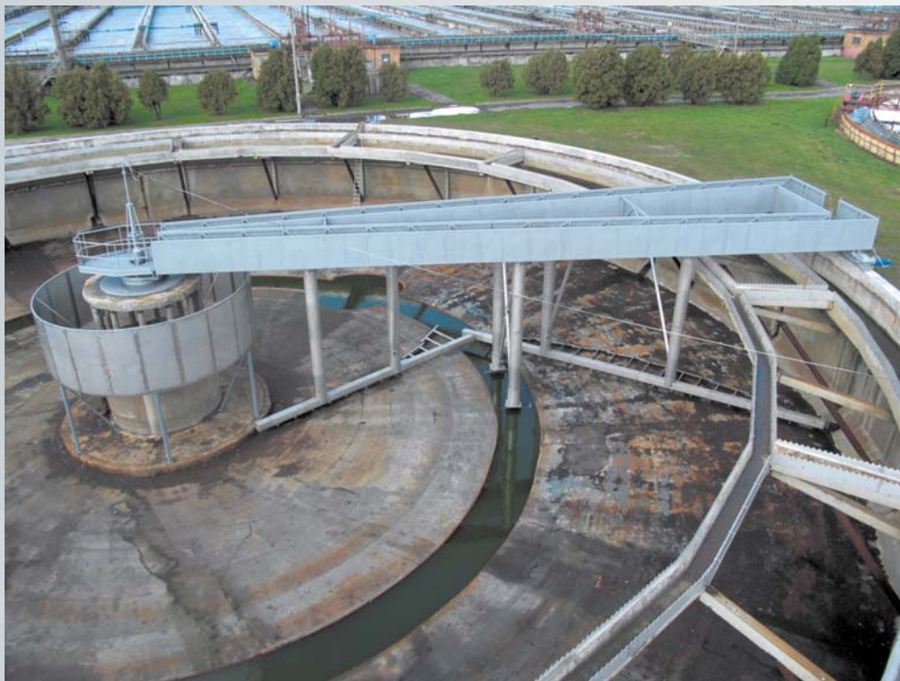
Рис. 5. ИЛОСКРЕБ МАРКИ ИЛ. КУРЬЯНОВСКИЕ ОЧИСТНЫЕ СООРУЖЕНИЯ
